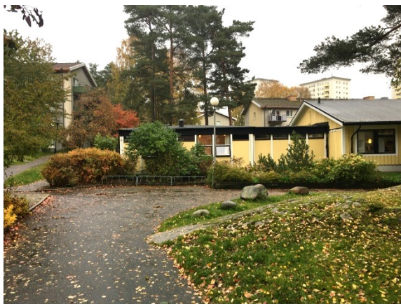
Entré från Adventsvägen.
