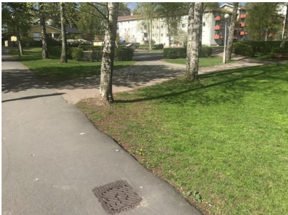
Planområdet sett från väster. Rännstensbrunn i gång- och cykelbanan som löper utmed den planerade förskolegården. Källa foto: Kretslopp och Vatten.
